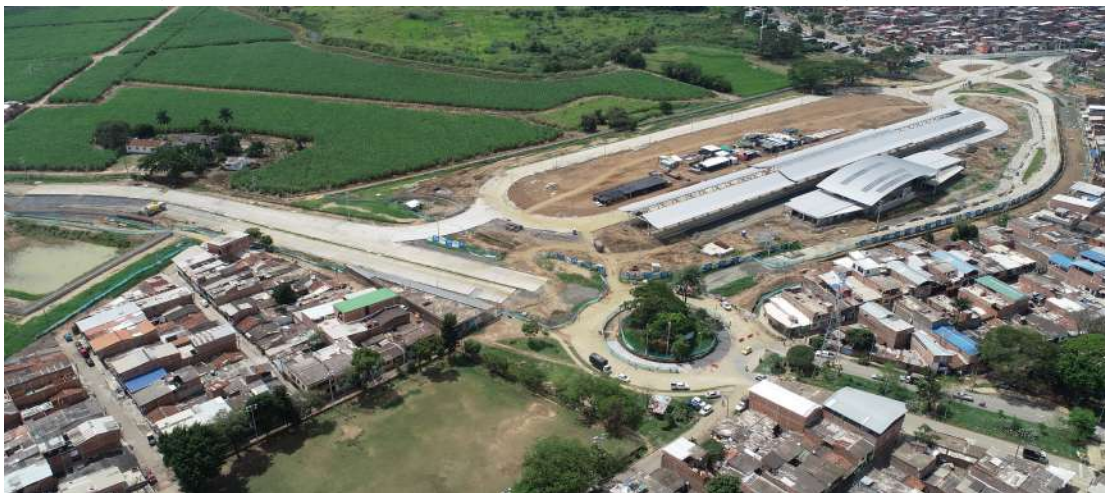
Figura 8 – Construcción de la Terminal de Cabecera Aguablanca.
