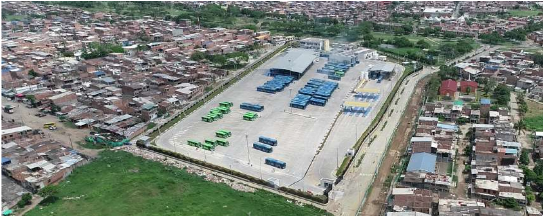
Figura 5 – Construcción y puesta en operación del Patio Taller Aguablanca.
