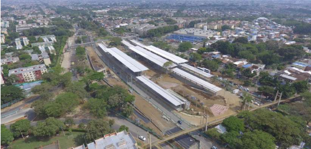
Figura 9 – Construcción de la Terminal de Intermedia Simón Bolívar.
