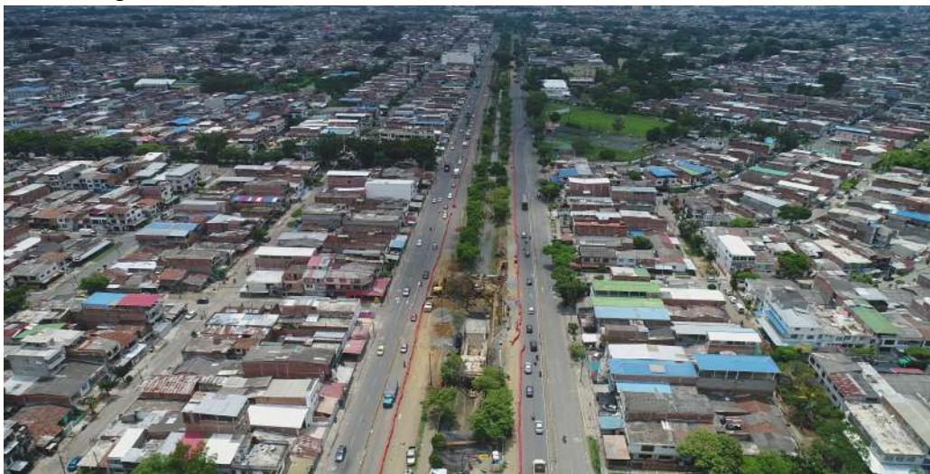
Figura 10 – Construcción del Corredor Troncal Oriental Tramo 2.
