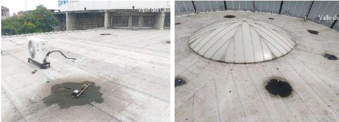
Figura 11 – Cubierta de la Terminal de Cabecera Andrés Sanín.
