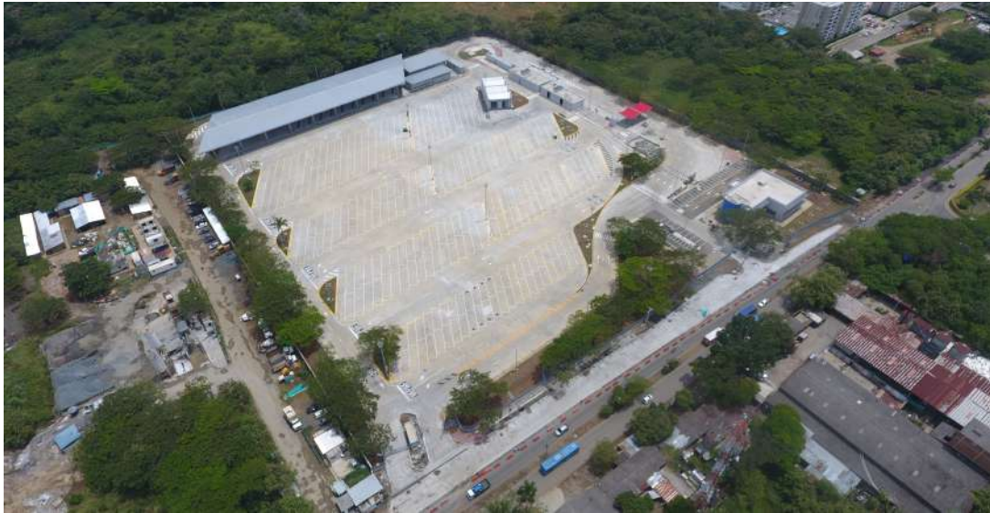
Figura 7 - Construcción y puesta en operación del Patio Taller Valle del Lili.
