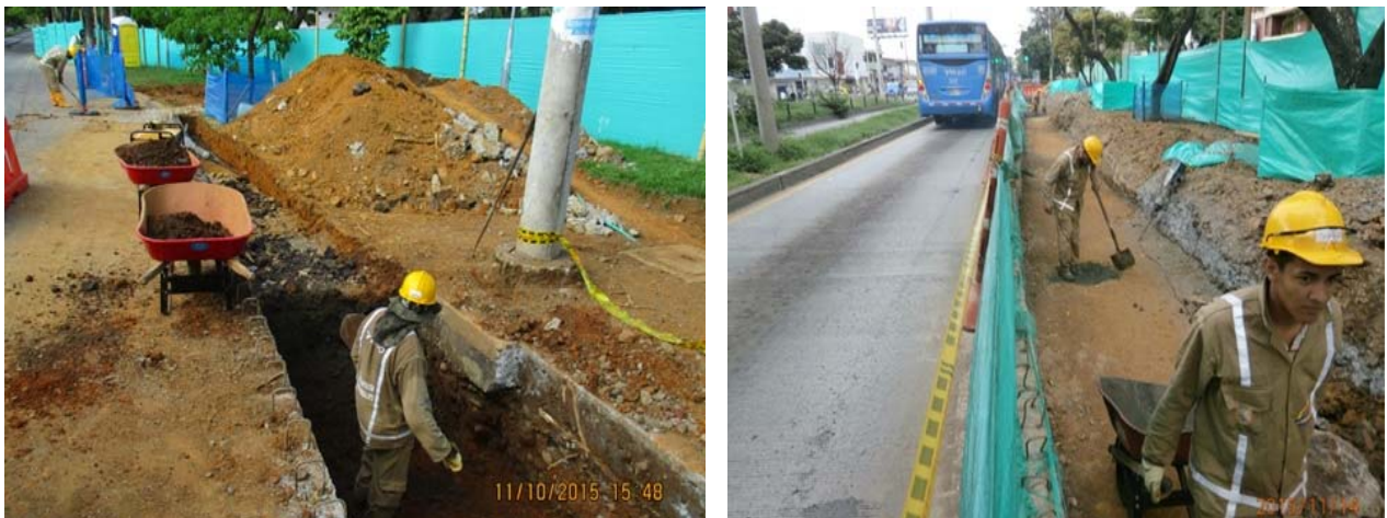
Construcción bahía de parqueo para buses alimentadores
