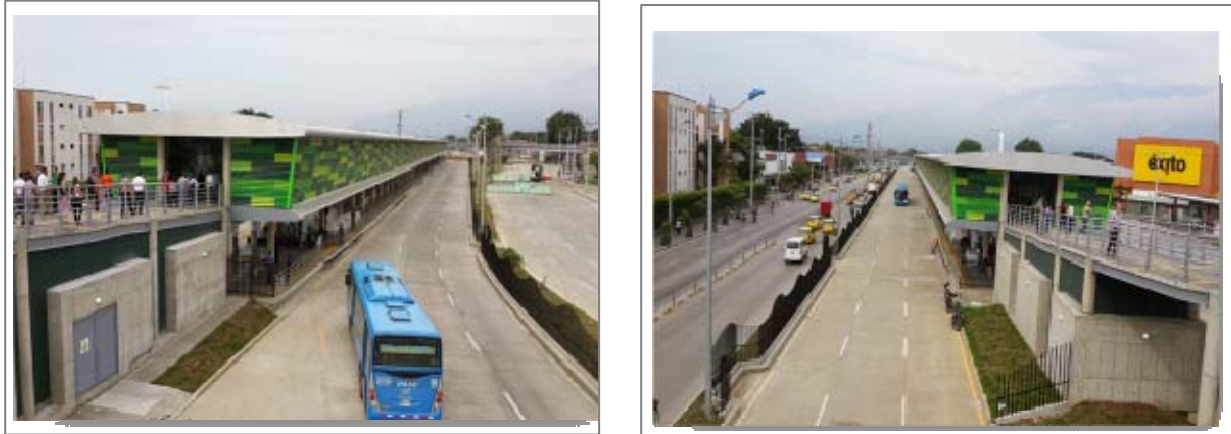
Figura 41. Imagen Terminal Calipso
