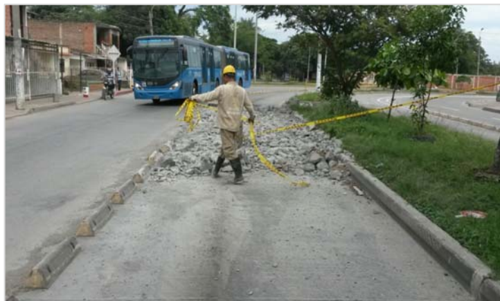
Figura 14. Detalle reparación losas de pavimento Carrera 15 con Calle 74 A
