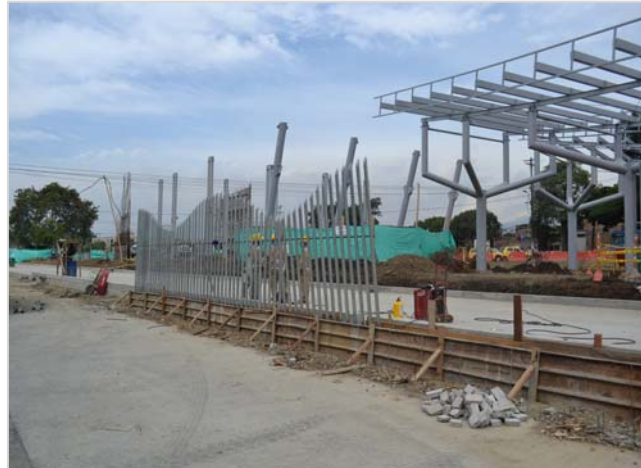
Figura 47: Instalación cerramiento, costado oriental
