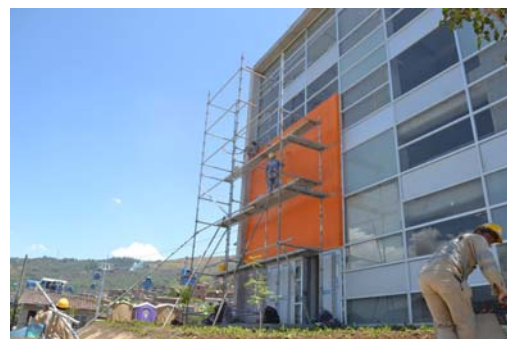
Ventanería de fachadas
