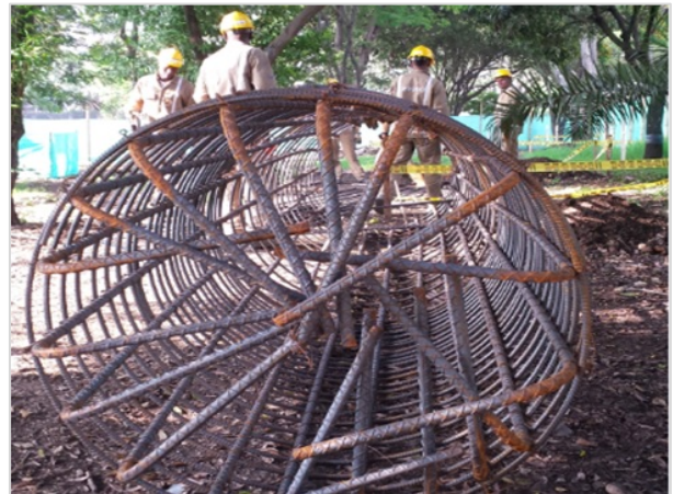
Acero de Refuerzo Pilotes Cimentación Puente Peatonal
