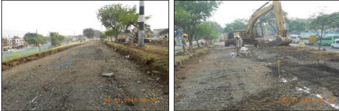
Figura 44: Cierre e intervención rampas del puente vehicular de la carrera 1 con calle 70
