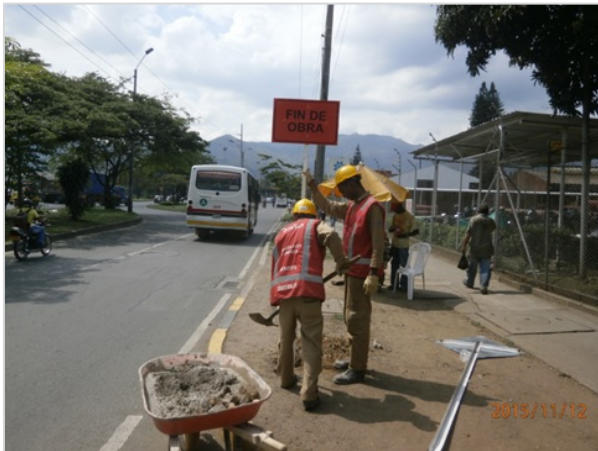
Implementación PMT Puente Peatonal Terminal Menga
