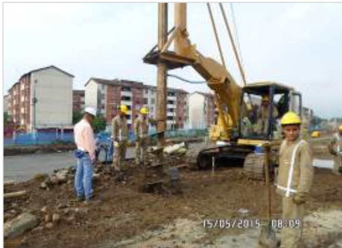
Figura 45: Excavación de pilotes para cimentación de la plataforma principal de la estación.
