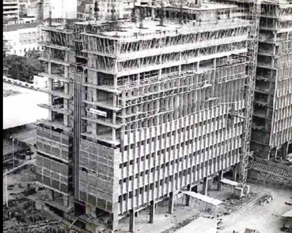
Inicios de la construcción del CAM, 1965
