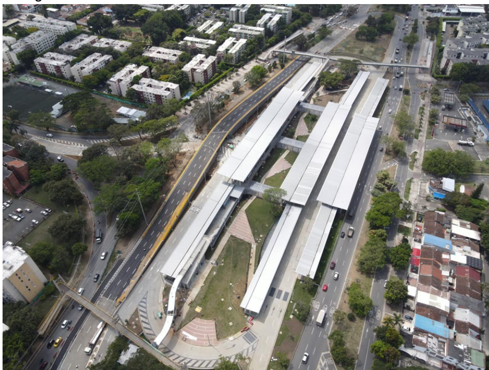
Figura 3 – Construcción de la Terminal de Intermedia Simón Bolívar
