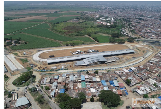
Terminal de Cabecera Aguablanca
